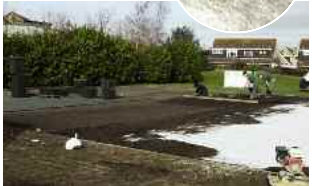
BGT100-Geotextil mit offenporigen BodPave®-Rasengittern zur Bodenverstärkung eingebaut
