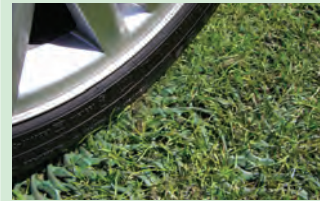
Nach dem Verlegen von GrassProtecta™
