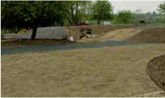
Installation: TurfProtecta wird auf neu angelegte Flächen ausgerollt und mit einer dünnen Schicht aus Erde und Saatgut bedeckt.
